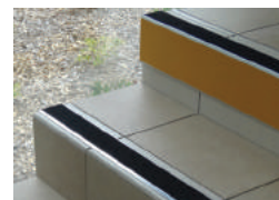
SÉCURISATION DES ESCALIERS
